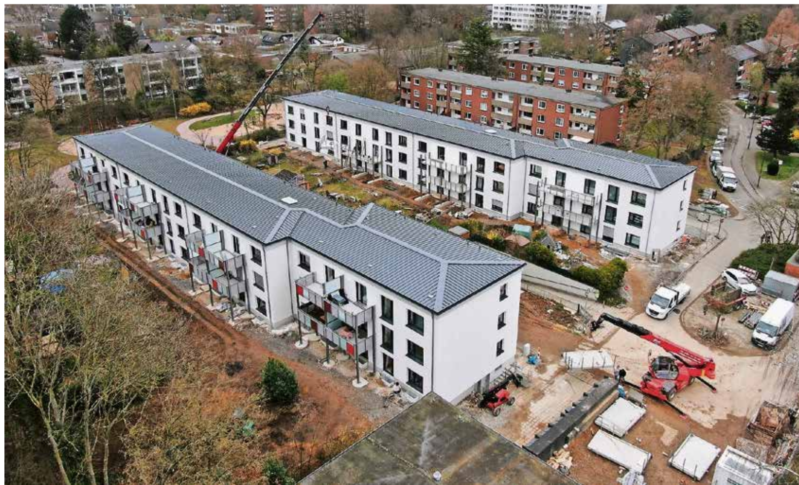
Zwei Häuserblocks sind bereits weitgehend fertig. An der Jakob-Kneip-Straße geht das Großprojekt voran.
