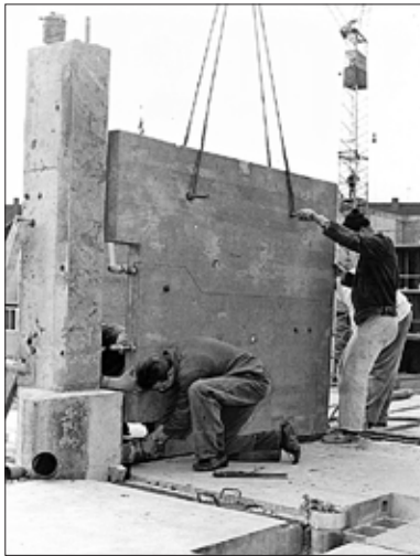
„Westdeutscher Plattenbau“: Montage vorgefertigter Wände.
