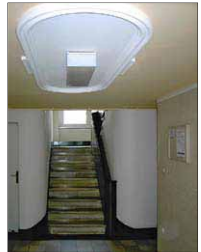
Ein Blick auf das Treppenhaus in der Oldenburgallee 46 a.
