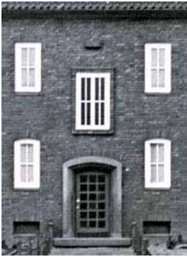
Sanierung der Hausfassaden in der Wohnanlage „Am Wald“ 1992.
