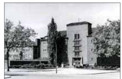
Das Anbetungskloster im Anschluß an den Baublock Badenallee und die Kirche des Klosters an der Preußenallee
