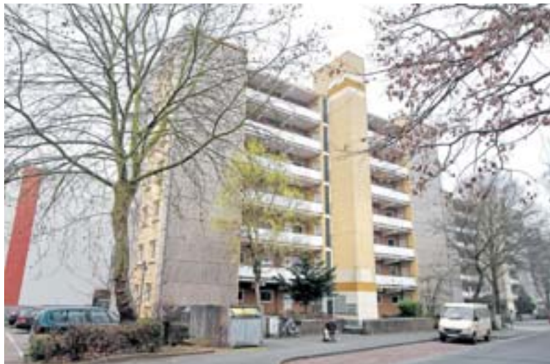
Diese Häuser an der Josef-Maria-Olbrich-Straße – typische Bausünden der 60er Jahre – sollen Mitte 2012 abgerissen werden.
